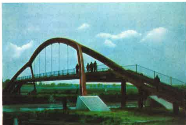
A kész híd
