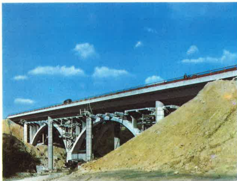
A völgyhid építés közben
