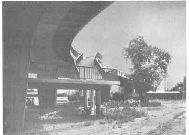
A gyalogjárda alatti konzol bordás kialakítása
