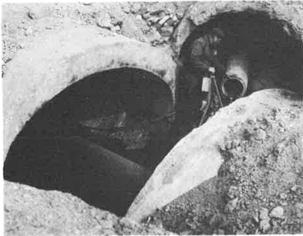
Meglevő 300/175 cm-es csatorna kiváltása
