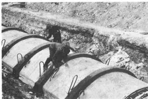
Az összeszerelt 300/187,5 cm-es csatorna
