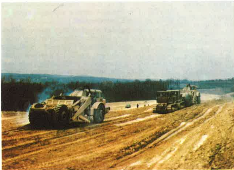
M 3 autópálya töltés építése Gödöllő határában
