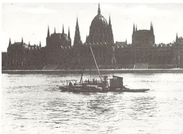
17. ábra Talajkutató fűrés a Duna medre alatti rétegek feltárására
