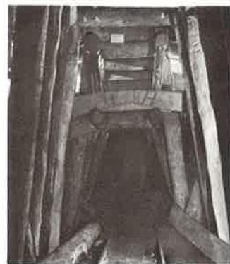
22. ábra Kihajtott kalott a boltozat bebetonozása előtt
