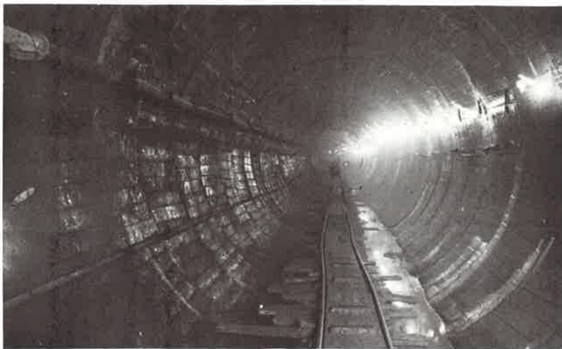
10. ábra Monolit betonfalazatú vonalalagút
