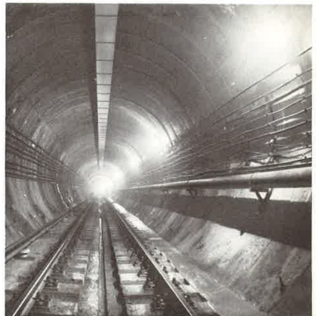
9. ábra Előre gyártott vasbeton-blokkos vonalalagút
