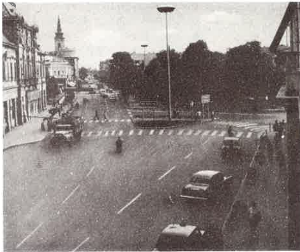
A 4. sz. főút nyíregyházi, Kossuth Lajos téri szakasza
