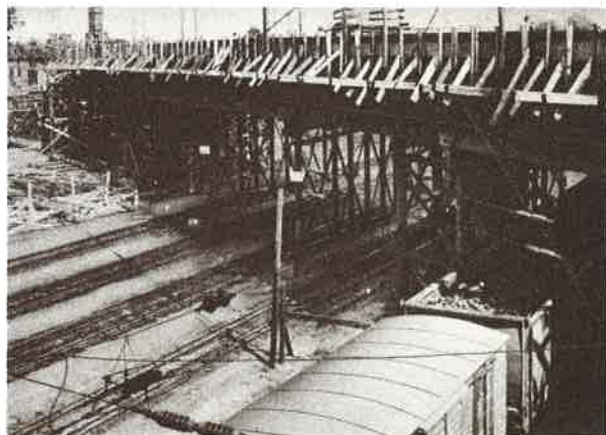
A homokkerti felüljáró építés közben
