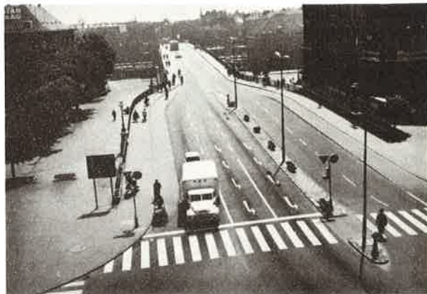
9. ábra A Lenin-híd csatlakozása az 1. sz. főúthoz
