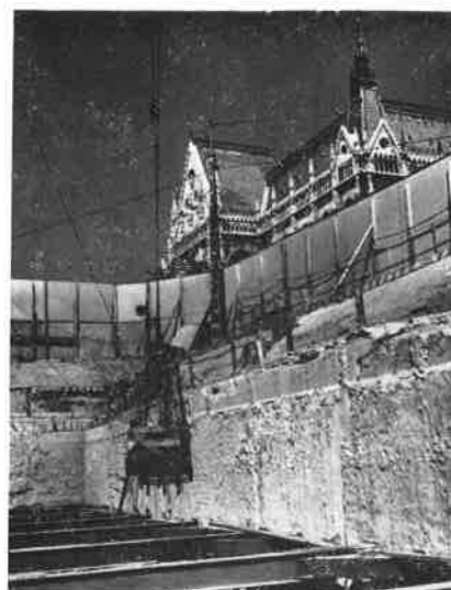
9. ábra Kidúcolt résfallyal körülzárt munkagödör
