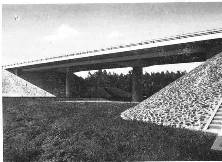
13. ábra Felüljáró a MÁV budapest—nagykanizsai vasútvonal felett (66+621 km-szelvény) — Tervező: Reviczky János
