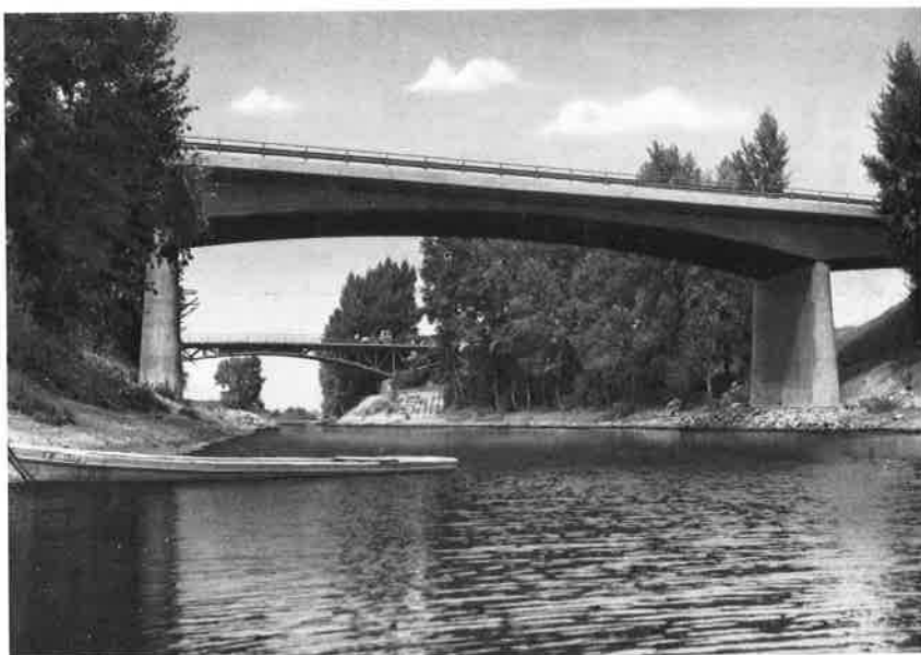
5. ábra A kész iparcsatorna-híd
