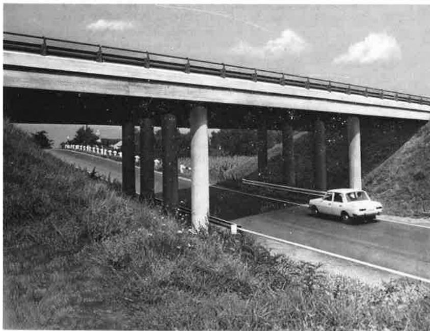
3. ábra Az Ipartelepi úti felüljáró képe
