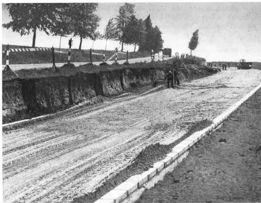
12. ábra Az új pálya építése az aszódi bevágásban
