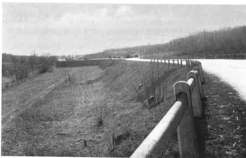
4. ábra Terepalakulatokhoz simuló vonalvezetésű szakasz Máriabesnyőnél
