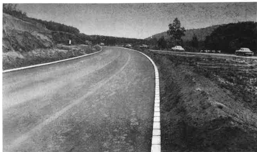
9. ábra Az új pálya megfelelő sugarú ívvel
