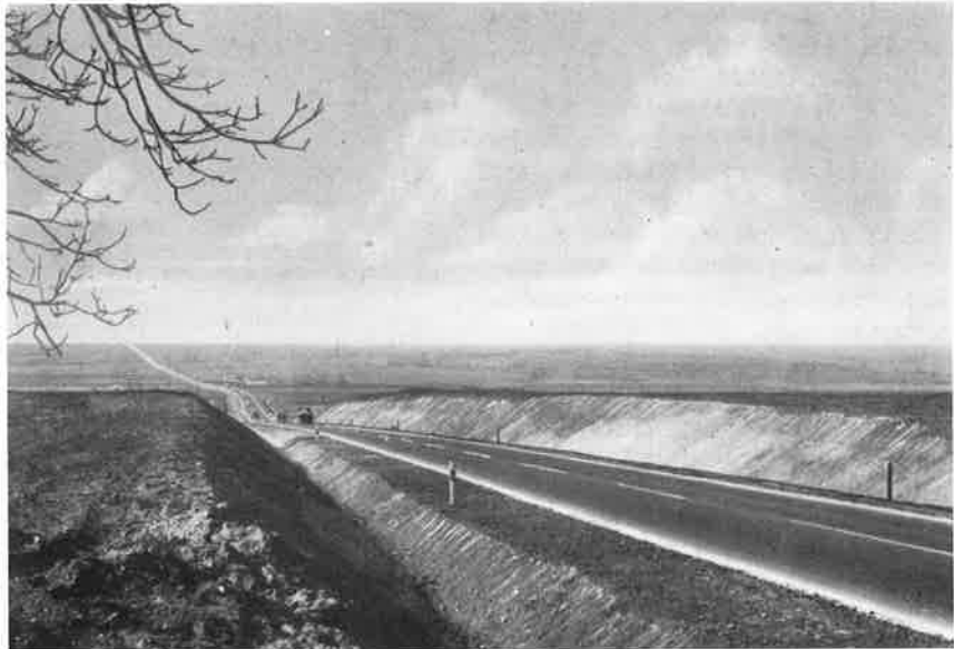
3. sz. főút Gyöngyös előtti szakasza
