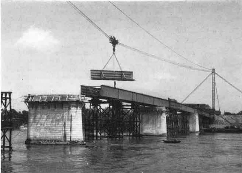
11. ábra Szabad szerelés kábeldaruval
