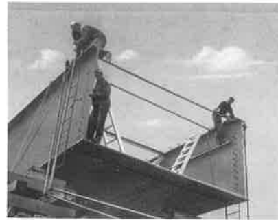
6. ábra A híd szerelés közben
