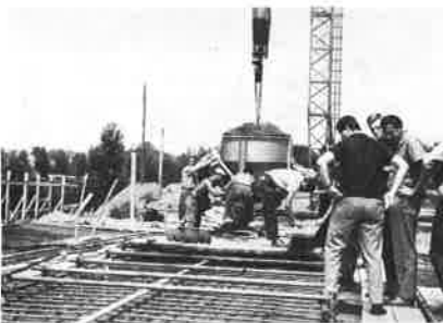
12. ábra Pályalemez betonozása
