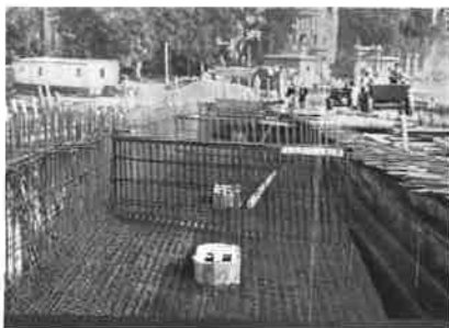
9. ábra A főtartó szekrényterének vasszerelése
