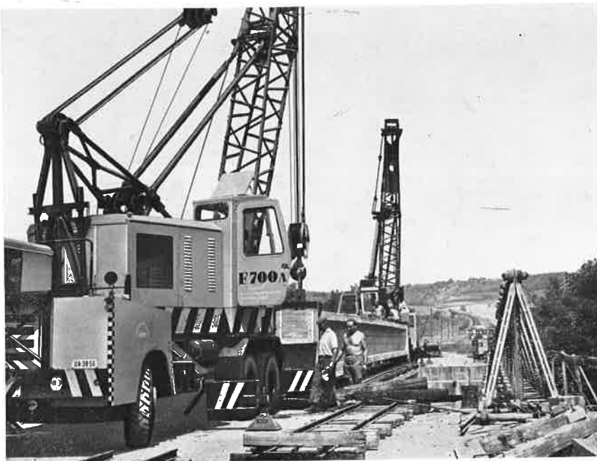
6. ábra Előregyártott feszített tartó beemelése. Tervezték: Reiner Endre és Ivády-Somogyi Dénes
