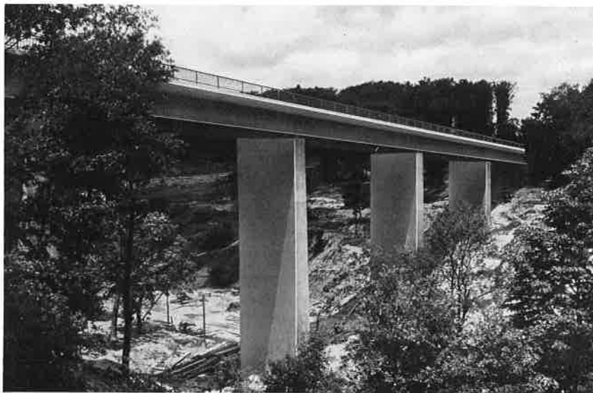
12. ábra Bolondúti völgyhíd. Tervezte: Bölcskei Elemér
