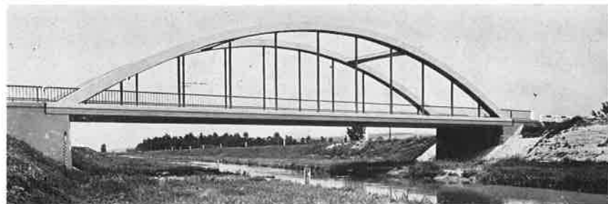
7. a. és b. ábrák Vonórudas ívhidak hagyományos és korszerűbb kialakítása. Tervezte: Lipták László
